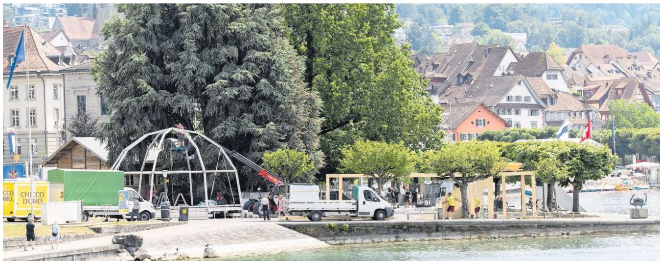
Das Gerüst des Chriesi-Pavillons steht noch.
