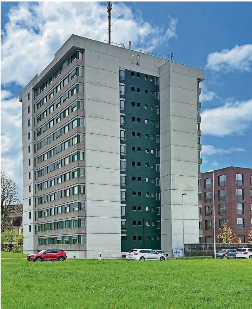
Die erste Bauetappe beginnt voraussichtlich im April 2024, die Sanierung wird voraussichtlich im Frühling 2026 abgeschlossen sein. Foto: ug
