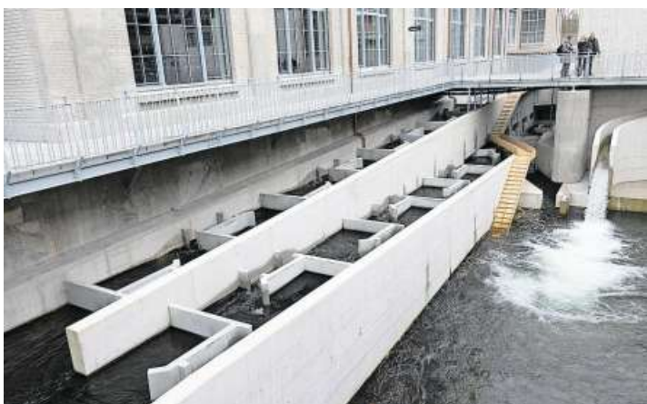
130 Meter legen die Fische in ihrer Aufstieghilfe zurück. Rechts davon ist die Bibertreppe aus Holz sichtbar.
